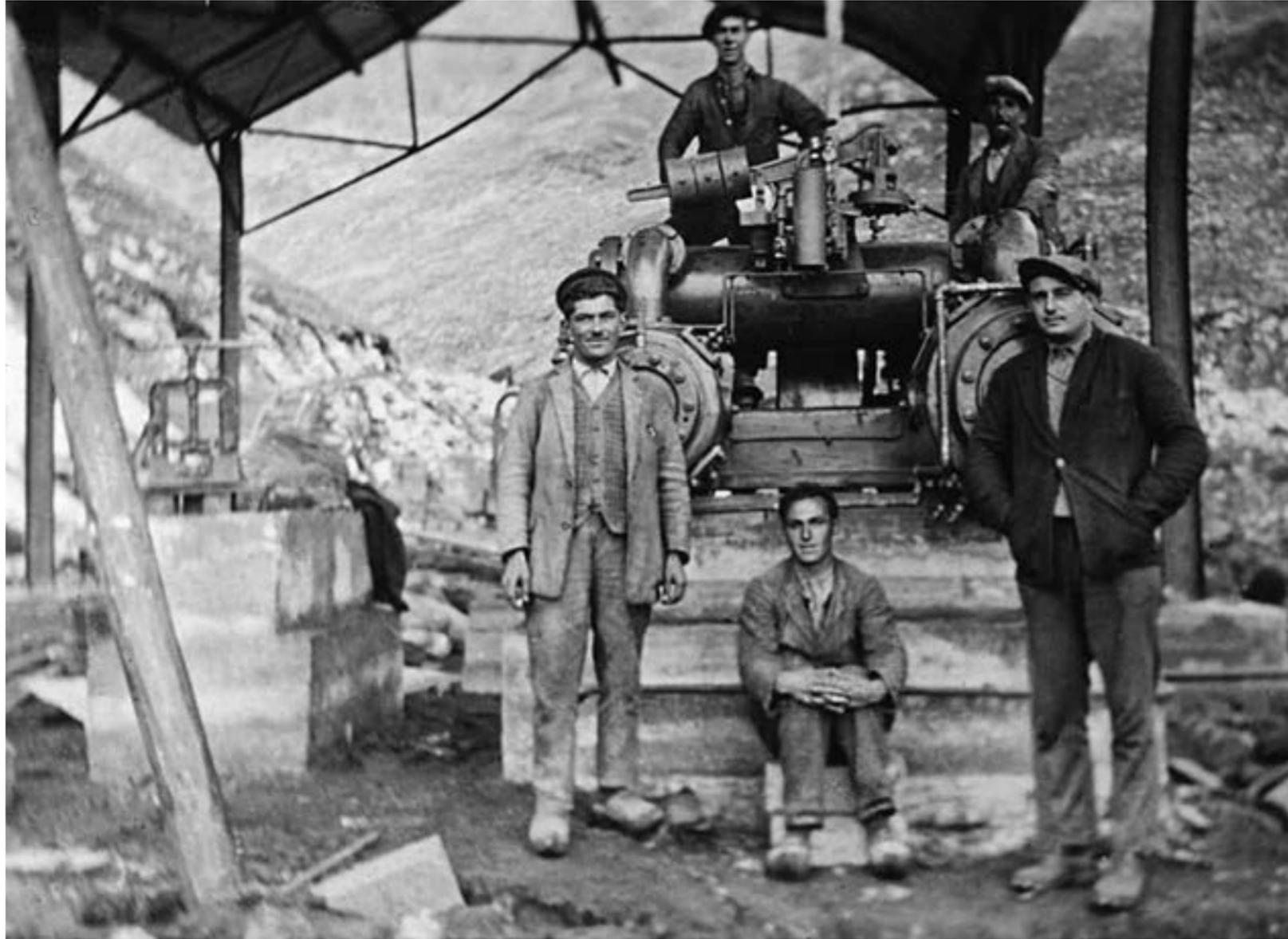
Mine de Sentein, compresseur pour la perforation mécanique, entre 1907 et 1912. Collection privée.
