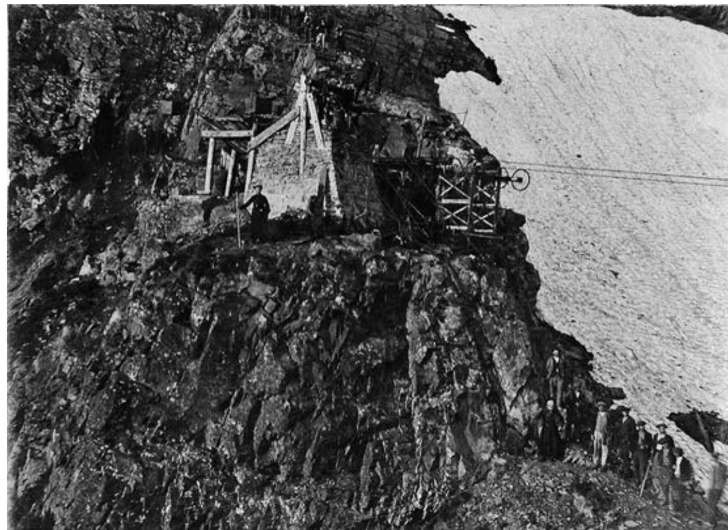
Mine de Bulard. Réception des bennes de la mine et station de départ du téléphérique à 2350 m, entre 1902 et 1918. Collection privée.
